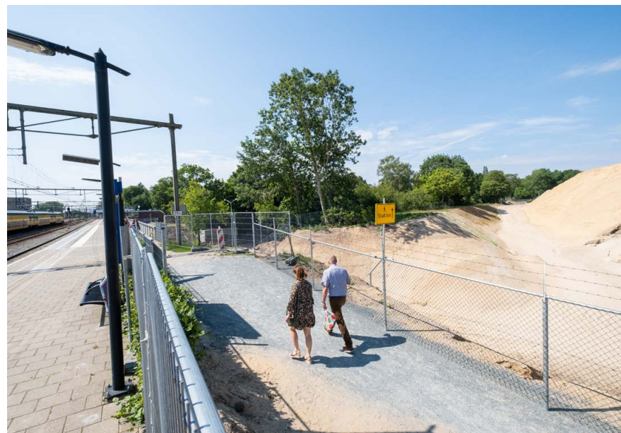
Foto: Werkzaamheden op station Ede-Wageningen
